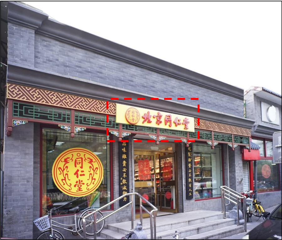
牌匾标识遮挡建筑立面特色装饰
