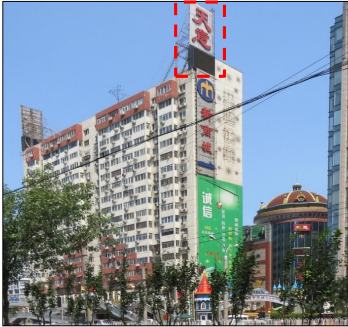
建筑顶部设置牌匾标识
