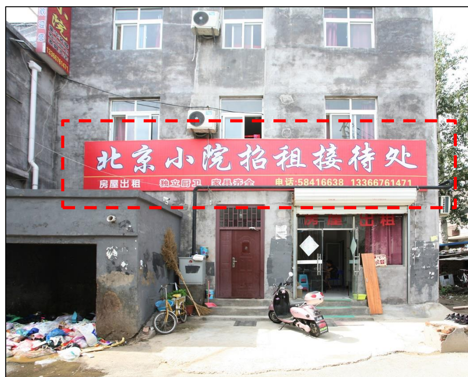
墙面式牌匾标识超出单位门面宽度
