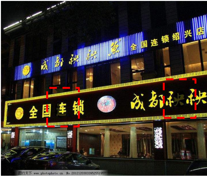
显亮设施部分损坏
